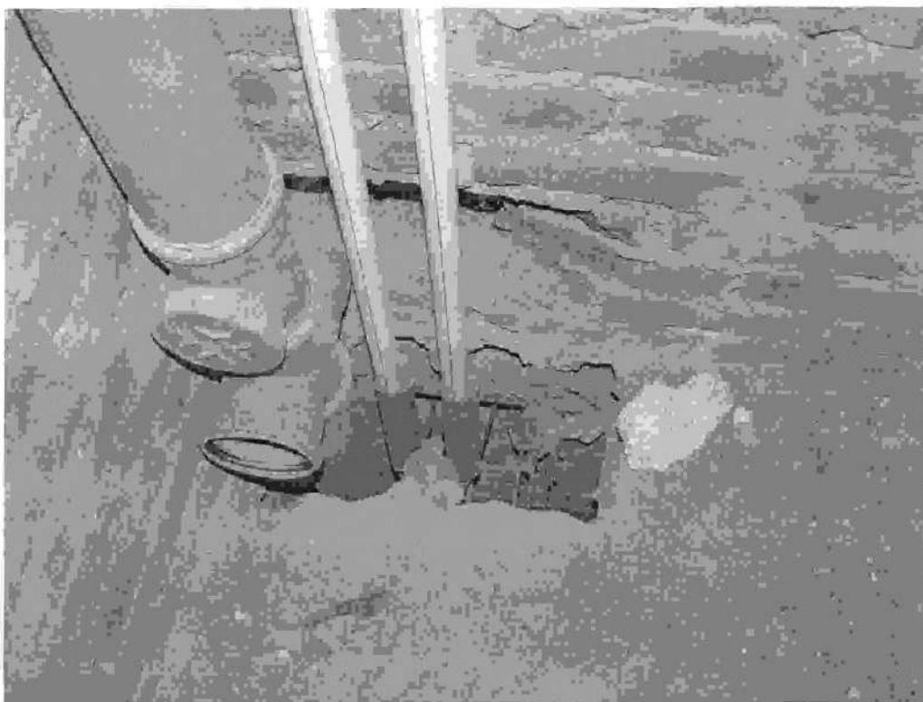
Фото 39. Отверстие в плите, перебито 4 пустоты. Секция 4. Состояние на 01.04.2015г.
