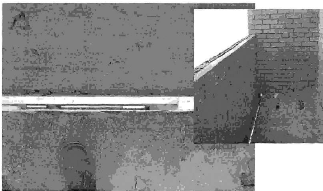
Фото 36. Крепление мет. уголка к балконной плите. Секция 4. Состояние на 01.04.2015г.
