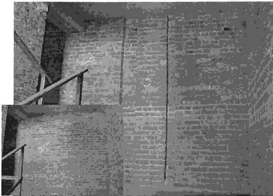
Фото 60. 4, 5 этаж. Секция 4 . Состояние на 01 04.2015г
