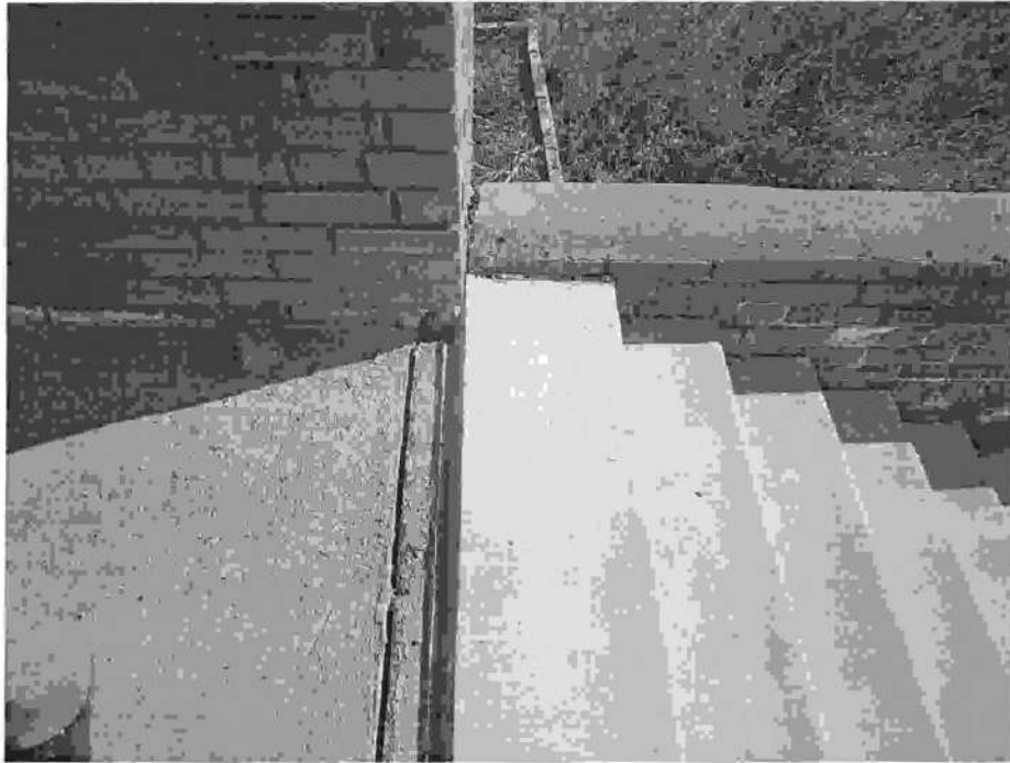
Фото 45. Крыльцо. Секция 7. Состояние на 01.04.2015г
