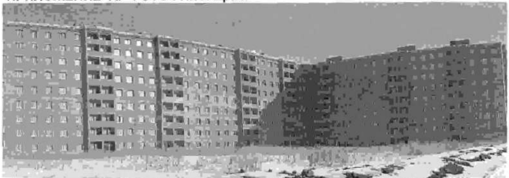
Фото 1. Дворовый фасад. Секция 6-12. Состояние на 27.02.2015г.
