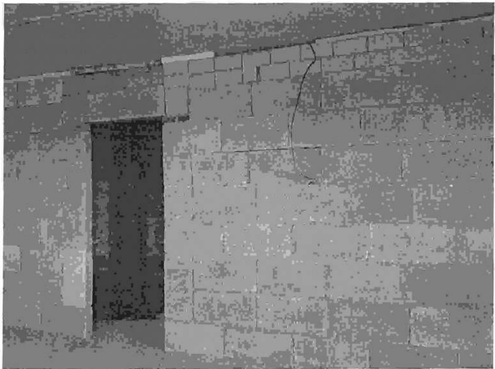
Фото 27. Перегородки. 9 секция. Состояние на 01.04.2015г.
