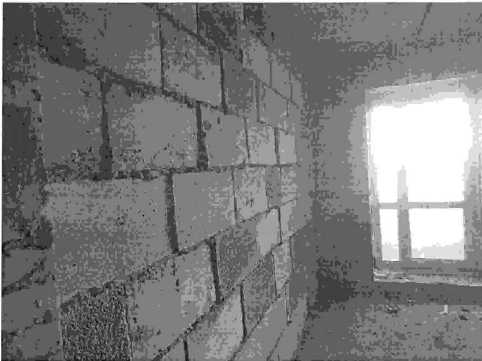
Фото 25. Перегородка. 9 секция. Состояние на 01.04.2015г.
