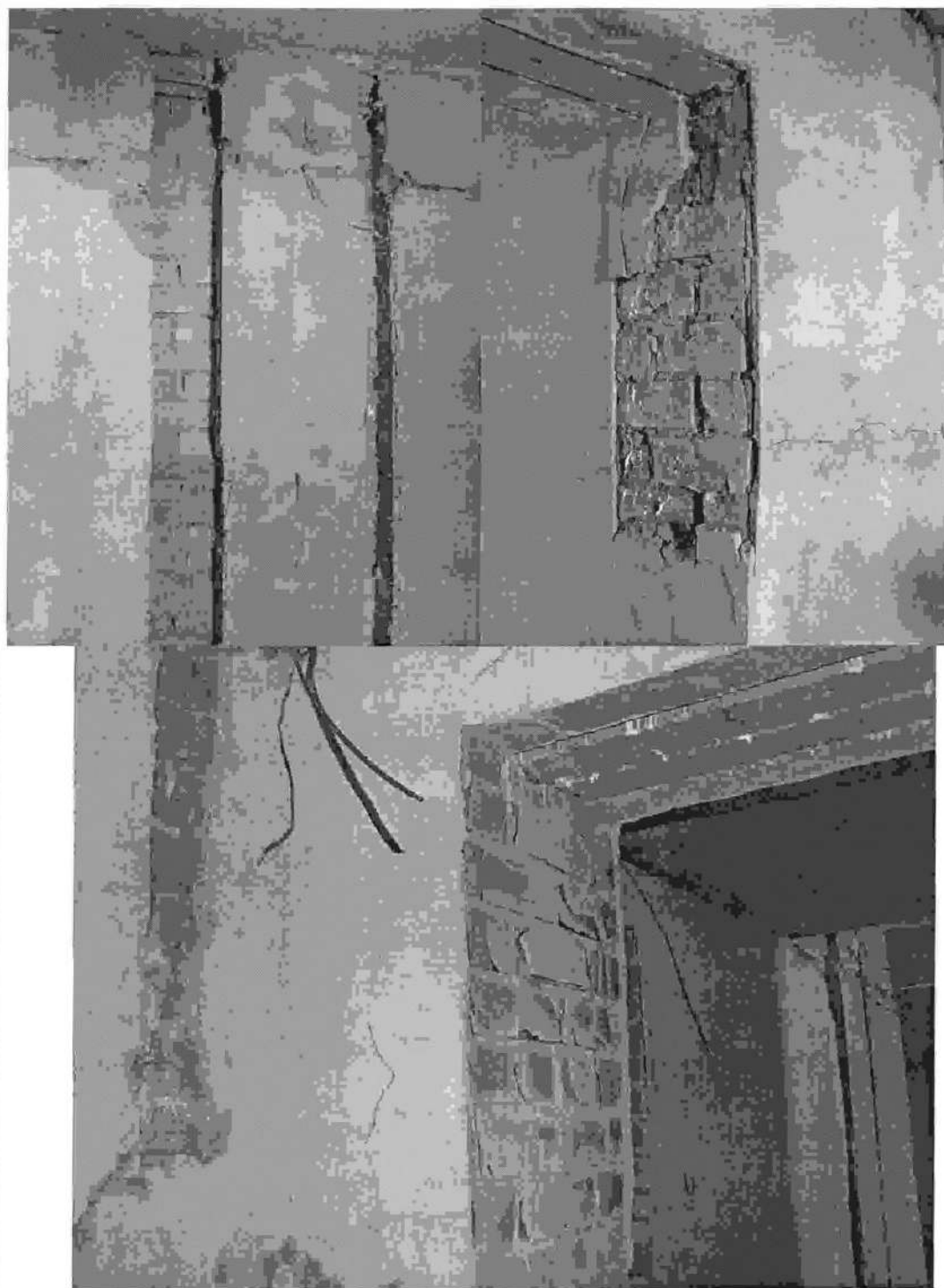
Фото 28. Внутренние несущие стены. 11 секция. Состояние на 01.04.2015г.
