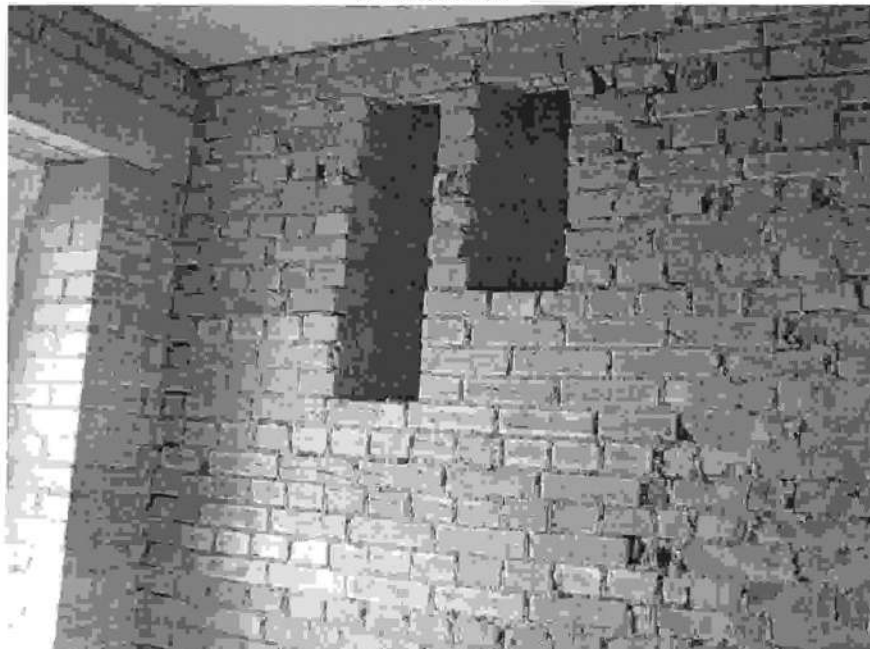
Фото 17. Вентшахты, секция 5. Состояние на 01.04.2015г.
