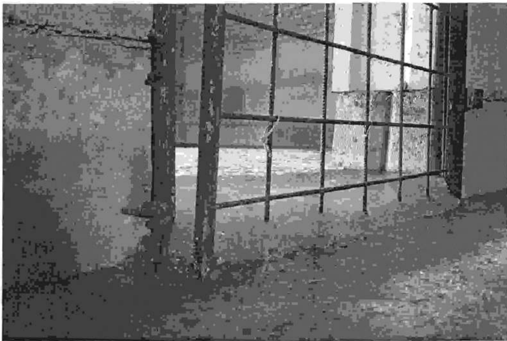
Фото 11. Подвал, секция 10. Состояние на 02.04.2015г.
