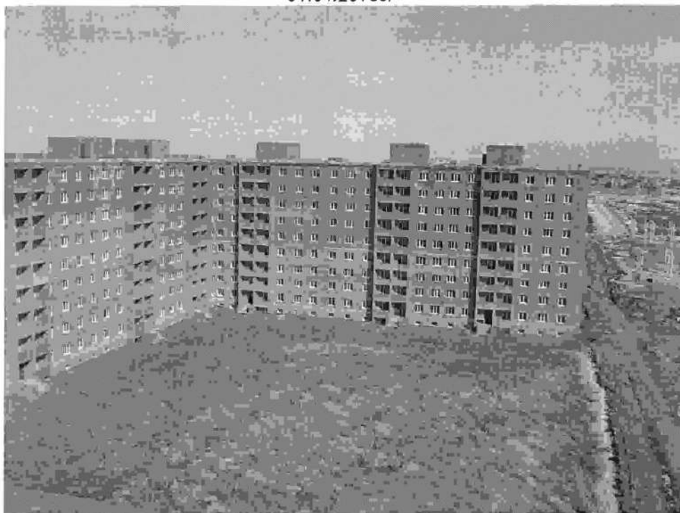
Фото 5 Дворовый фасад, благоустройство. Секция 7-12. Состояние на 01.04.2015г.
