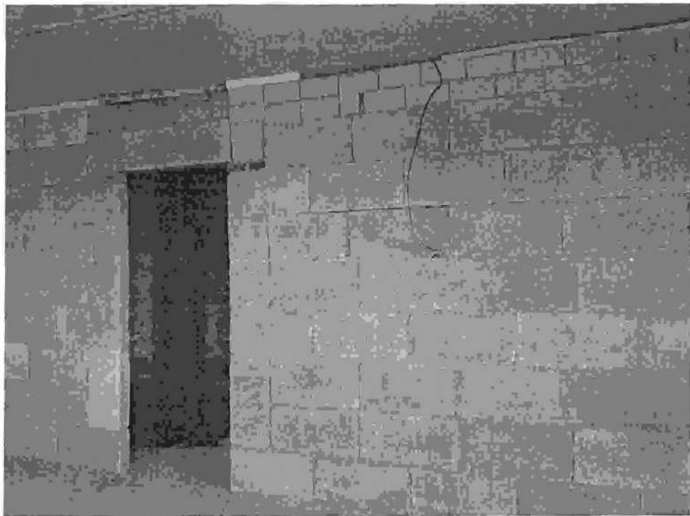
Фото 27. Перегородки. 9 секция. Состояние на 01.04.2015г.
