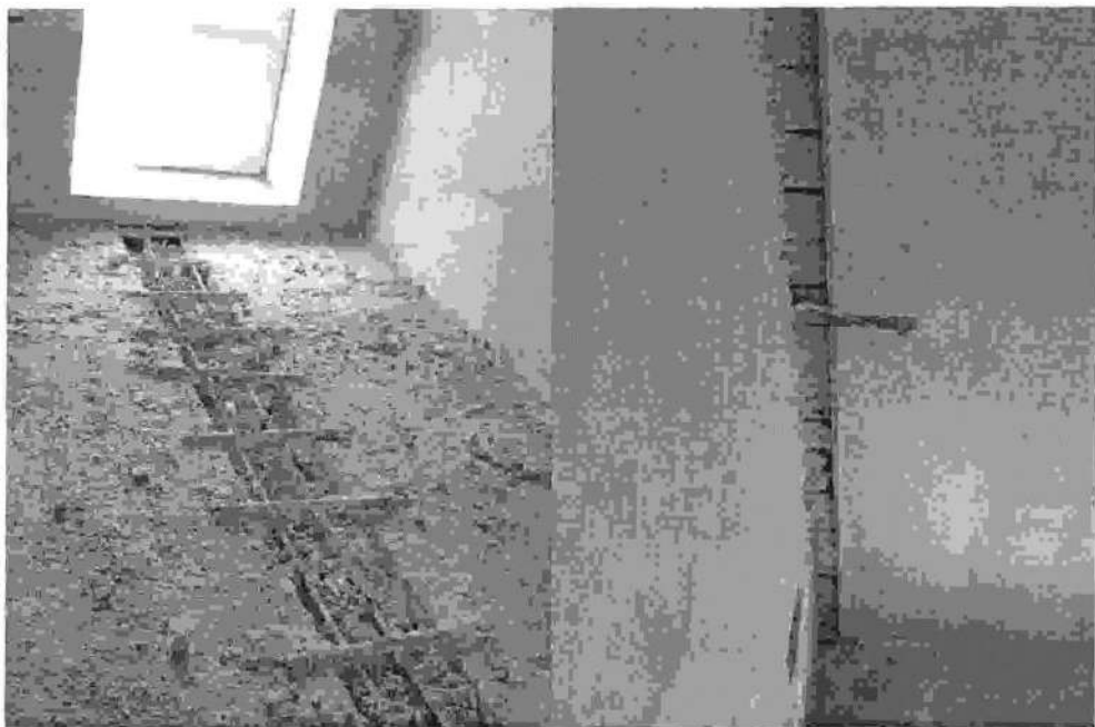
Фото 34. Монолитные участки. Секция 3. Состояние на 01.04.2015г.
