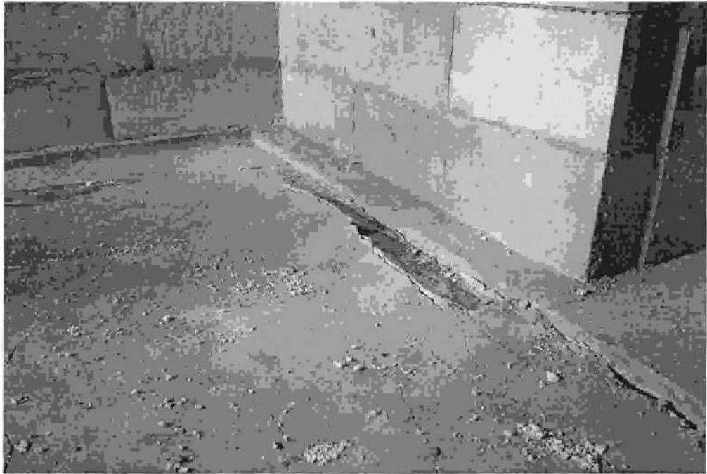
Фото 8. Подвал, секция 9. Состояние на 02.04.2015г.
