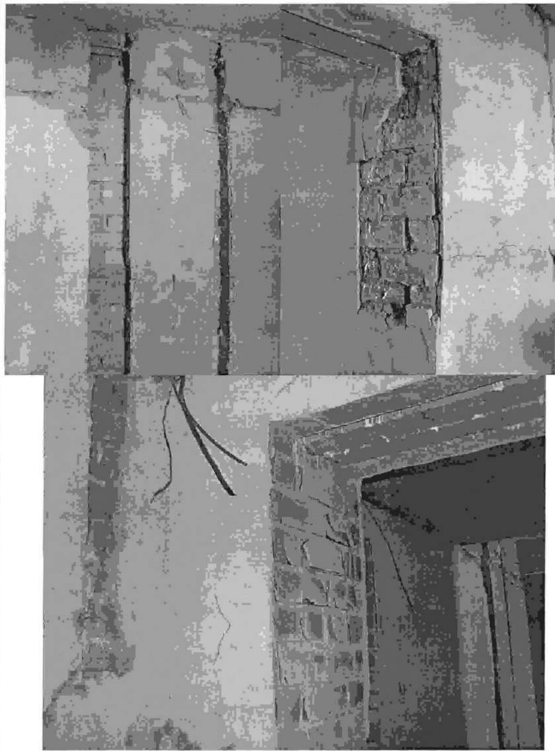
Фото 28. Внутренние несущие стены. 11 секция. Состояние на 01.04.2015г.
