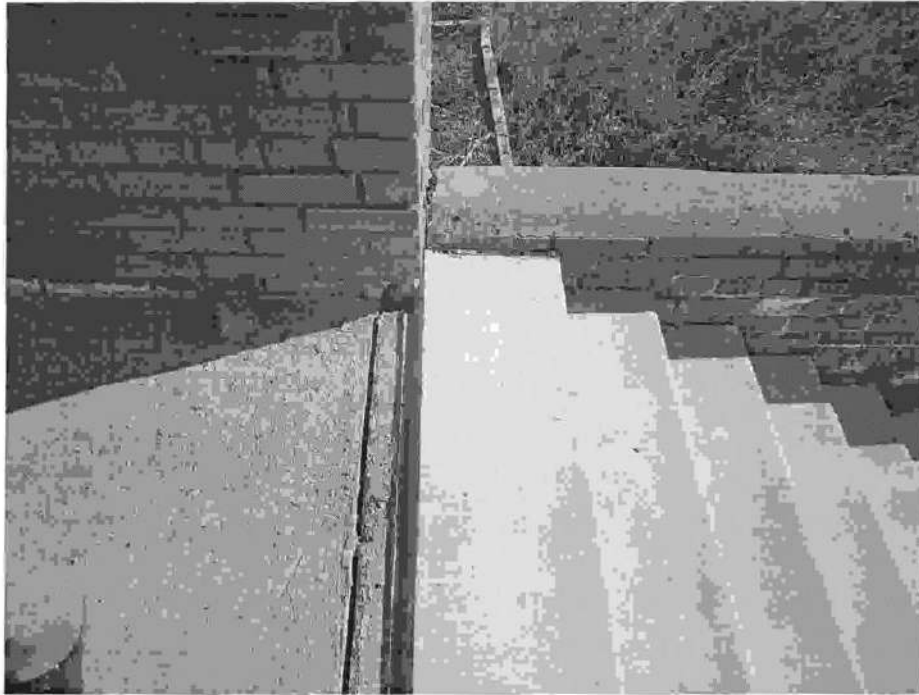
Фото 45. Крыльцо. Секция 7. Состояние на 01.04.2015г
