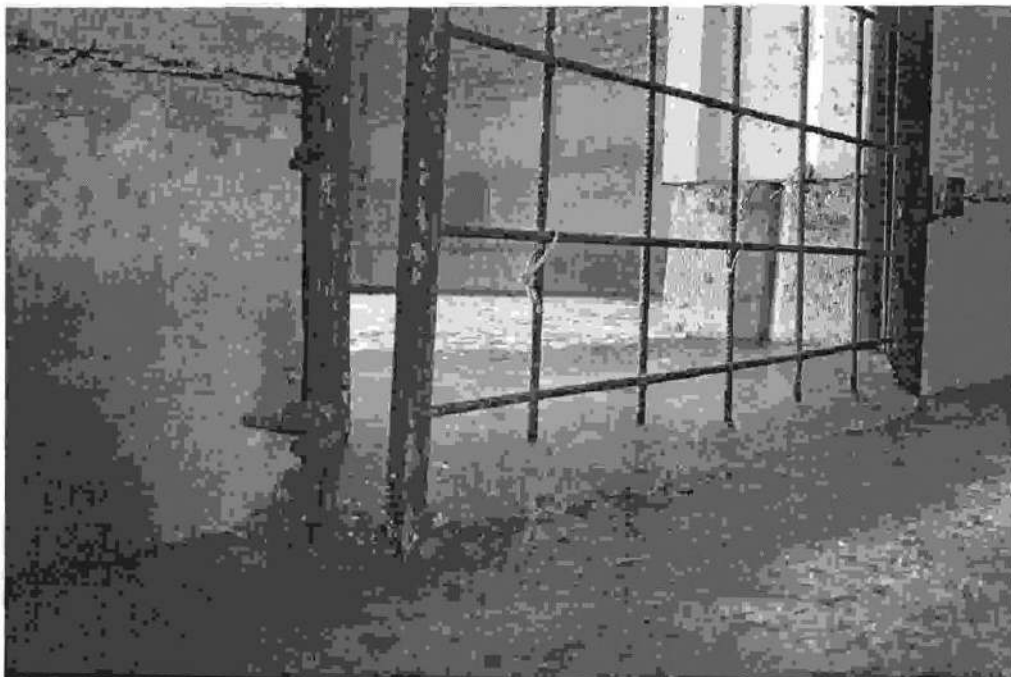
Фото 11. Подвал, секция 10. Состояние на 02.04.2015г.
