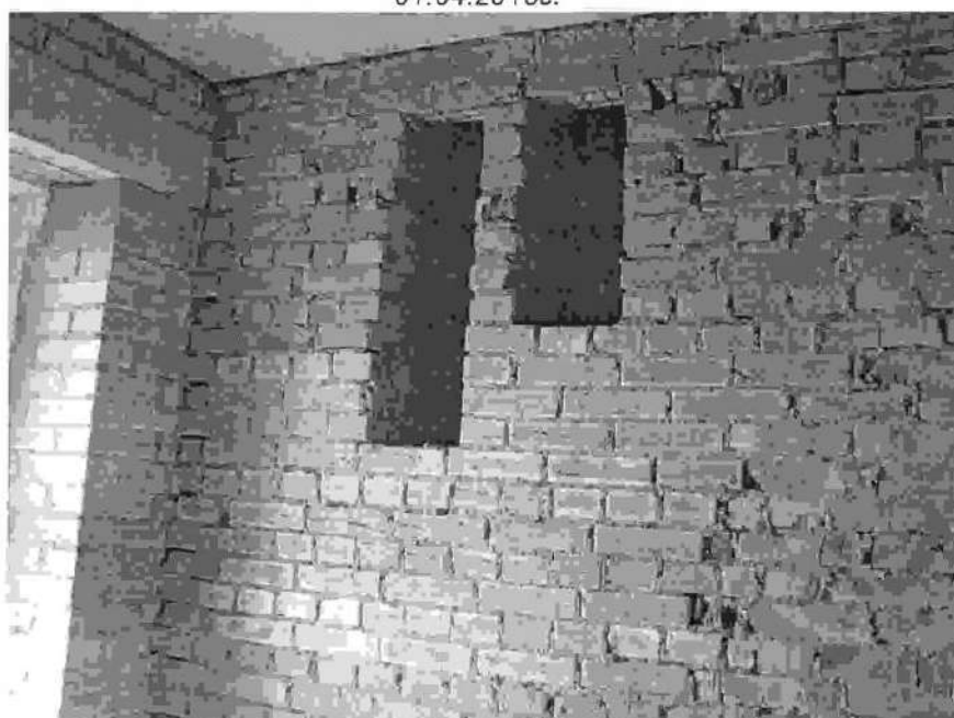
Фото 17. Вентшахты, секция 5. Состояние на 01.04.2015г.
