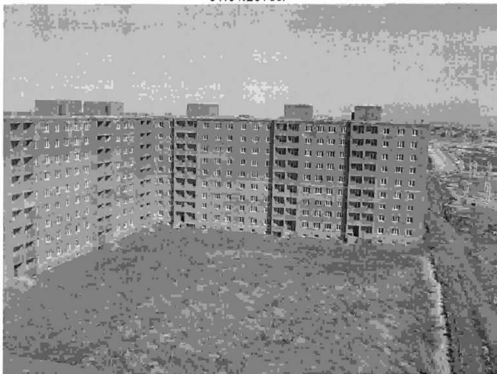
Фото 5 Дворовый фасад, благоустройство. Секция 7-12. Состояние на 01.04.2015г.
