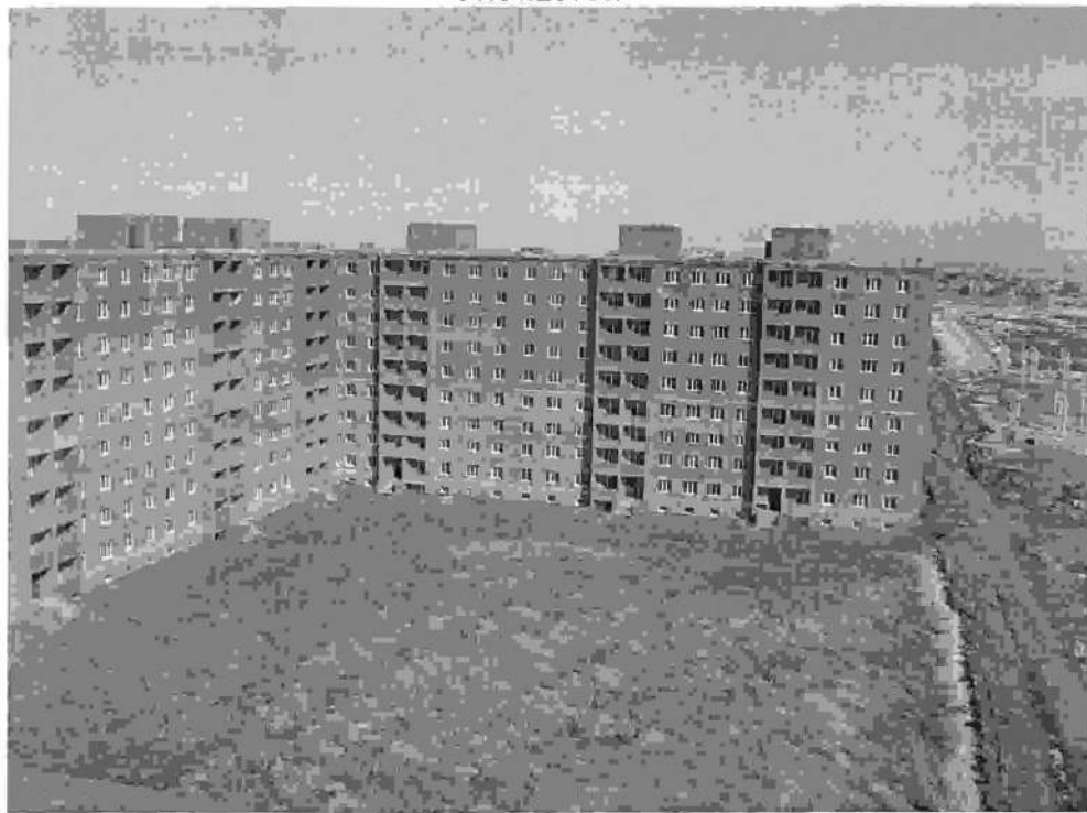
Фото 5 Дворовый фасад, благоустройство. Секция 7-12. Состояние на 01.04.2015г.
