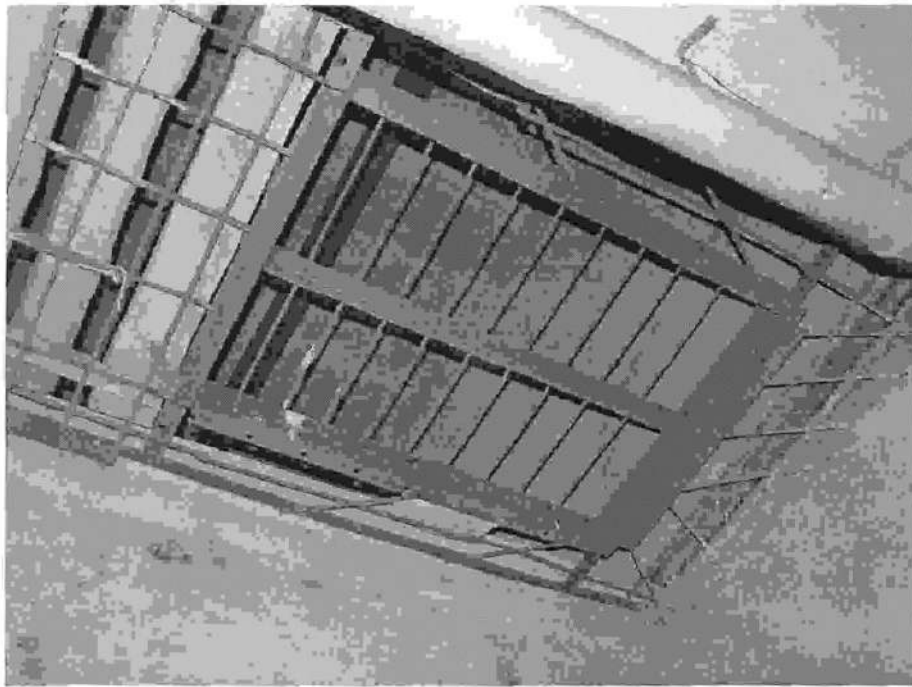
Фото 35. Монолитный участок с люком машинного помещения лифта. Секция 3. Состояние на 01.04.2015г.
