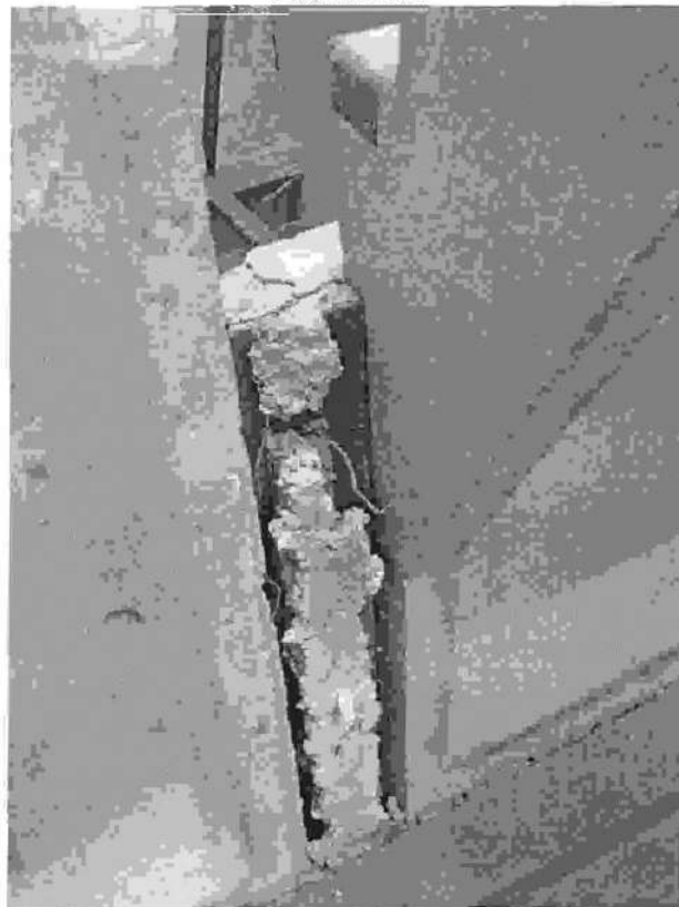
Фото 48. Монолитный участок лестничного марша. Секция 11 . Состояние на 01.04.2015г
