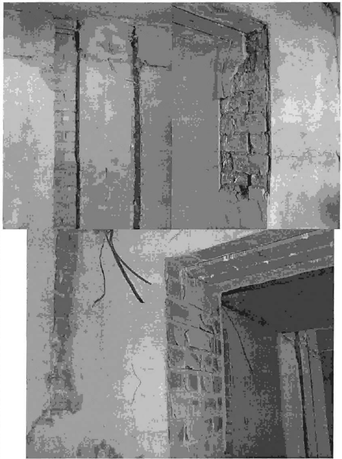
Фото 28. Внутренние несущие стены. 11 секция. Состояние на 01.04.2015г.
