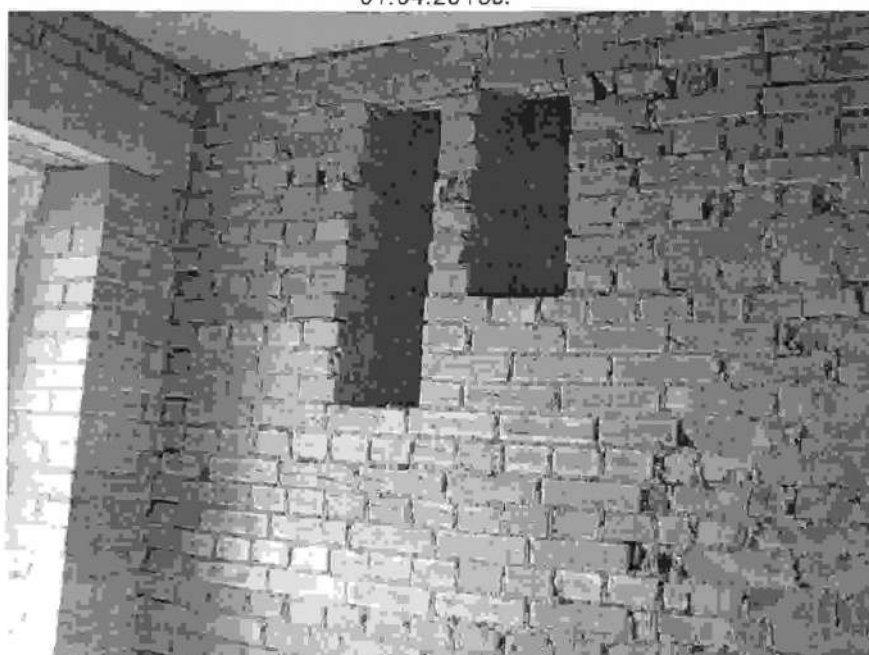
Фото 17. Вентшахты, секция 5. Состояние на 01.04.2015г.
