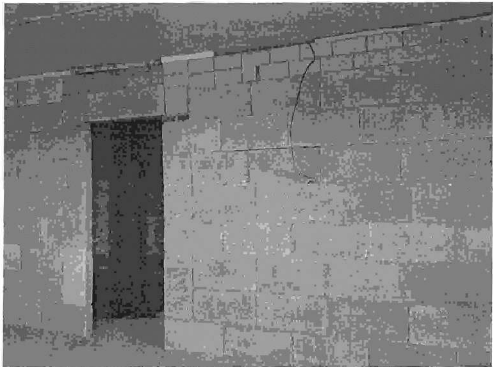
Фото 27. Перегородки. 9 секция. Состояние на 01.04.2015г.
