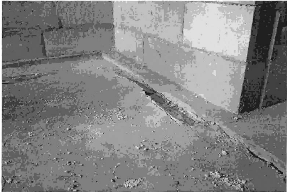
Фото 8. Подвал, секция 9. Состояние на 02.04.2015г.
